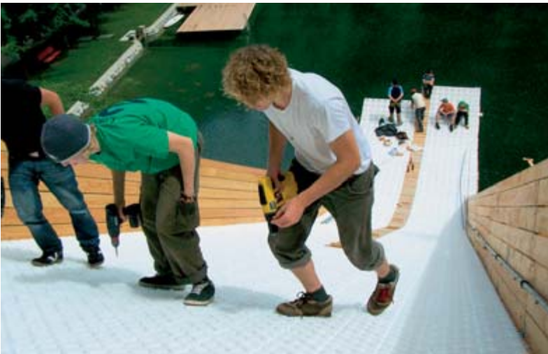
Das Verlegen des robusten Belages SKITRAX ist rasch und problemlos möglich. In Oberaudorf waren die Jugendlichen fleißig am Werken.
